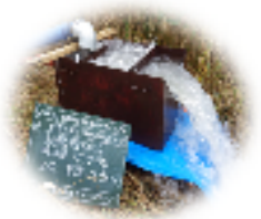
揚水試験状況
